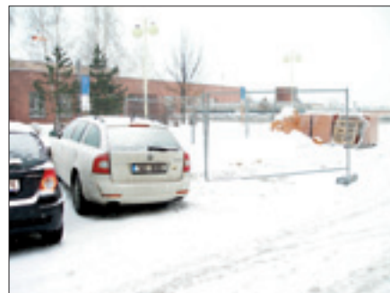
Část parkovacích míst zabírají také právě probíhající rekonstrukce...
